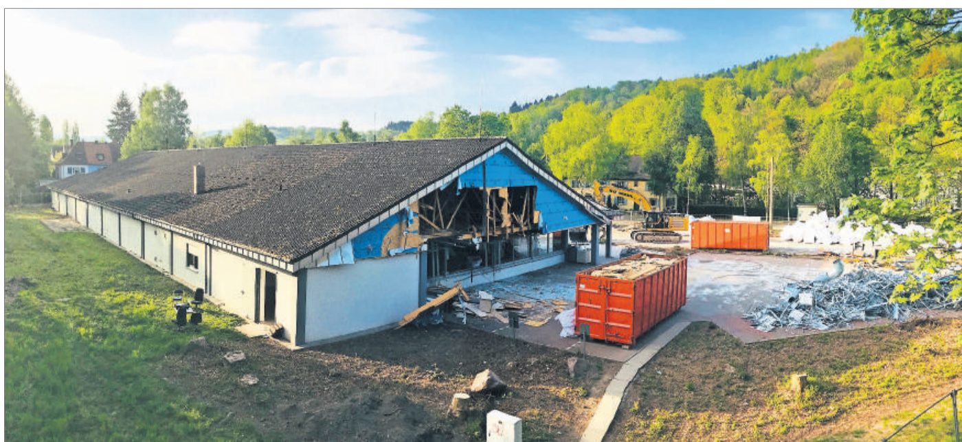
Der Abriss läuft: Bis November soll hier eine neue Aldi-Filiale entstehen.
