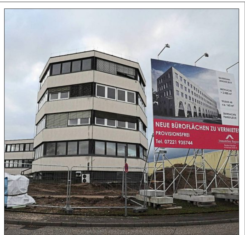
EINEM NEUEN GESCHÄFTSHAUS und einem Lebensmittelmarkt wird das Achteck in Haueneberstein weichen. Foto: Kappler
